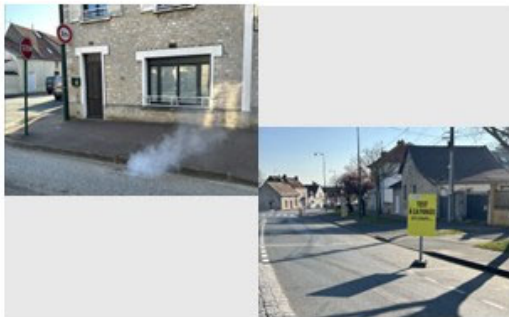
Test à la fumée par les exploitants
